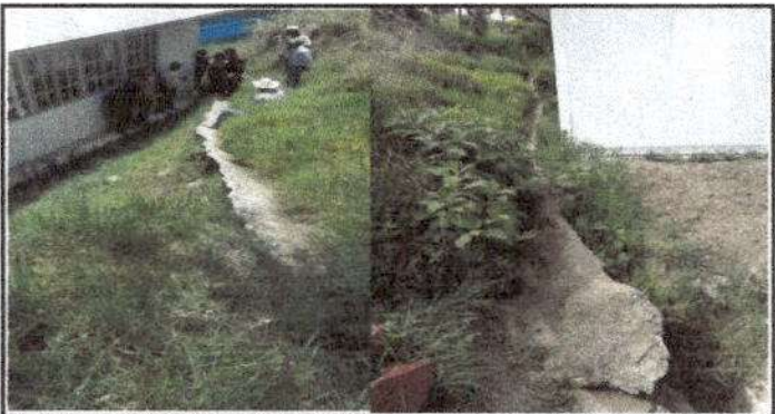
Foto 5: Estado actual de cunetad de concreto
