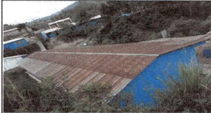
Foto 1: Estado actual del techo.
